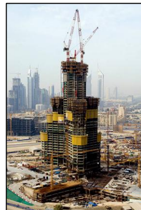
Phase de construction de la tour
